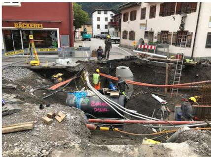
Eine Druckrohrleitung für das Kraftwerk Alvierwerk 2 und diverse Bestandsleitungen wurden als wasserrechtliche Ersatzmaßnahme vom Lug bis zum neuen Alvierwerk 2 der Firma Getzner verlegt.
